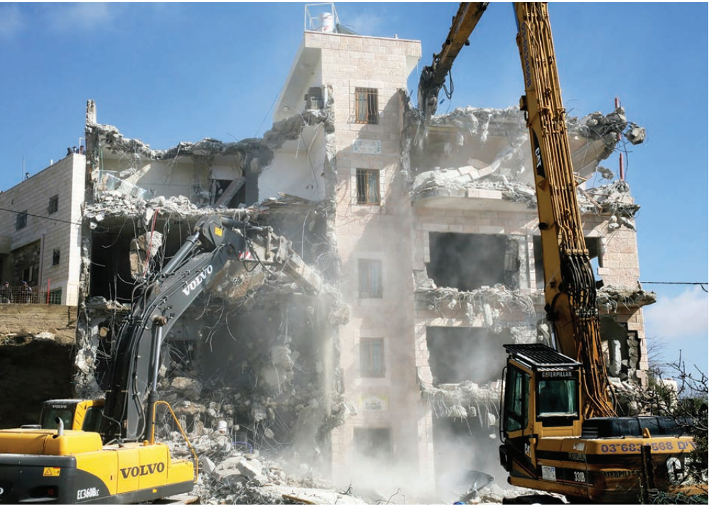
هدم مبنى في صور باهر جنوب القدس
