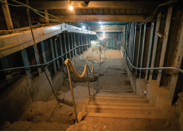
نفق "طريق الحجّاج" من داخله
