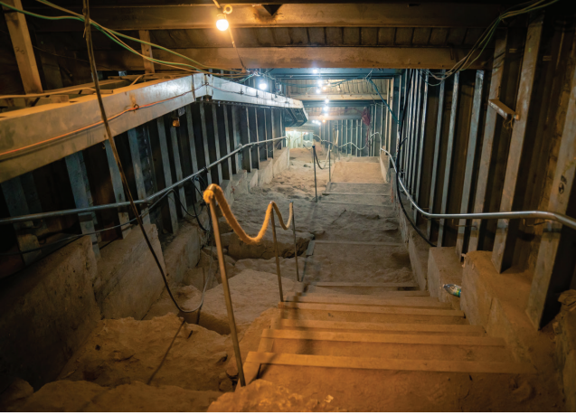
نفق "طريق الحجّاج" من داخله
