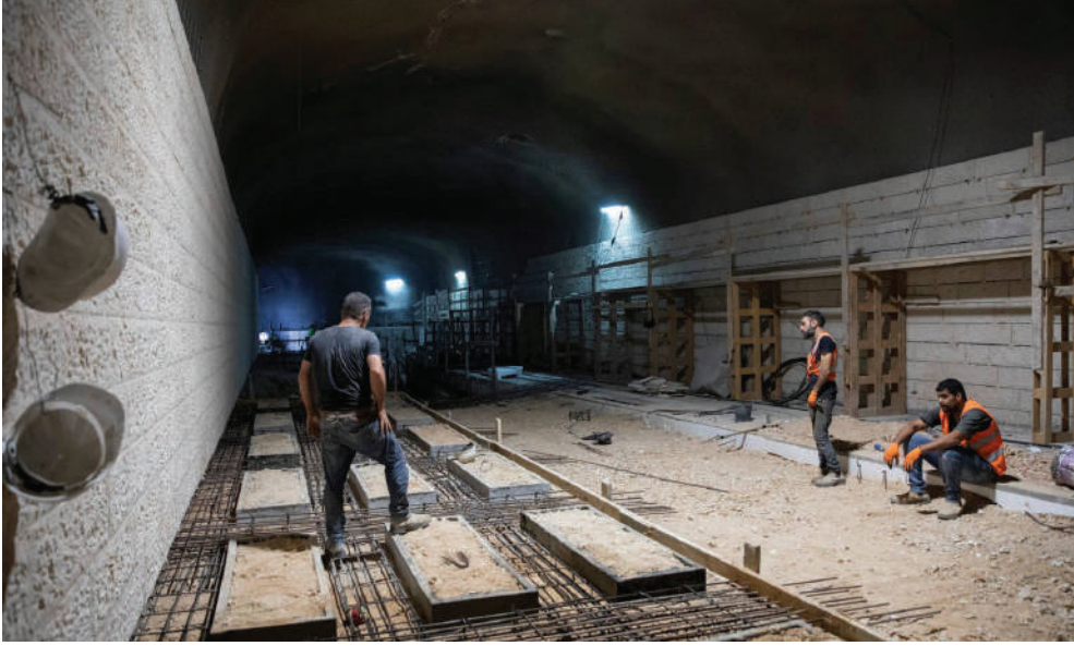
عمال يعملون في بناء مقبرة يهودية ضخمة تحت الأرض شرق الأقصى
