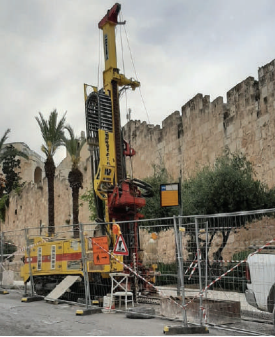
حفريات تجريبية قرب سور البلدة القديمة لتمديد القطار السريع (تاريخ الصورة: 2020/5/9)
